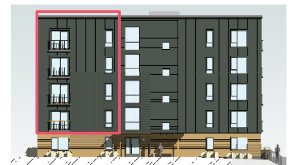
Hus A. Fasade mot nord.
