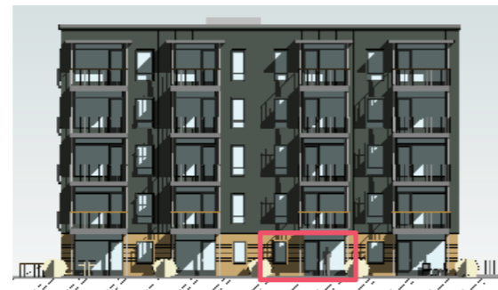
Hus A. Fasade mot sør.
