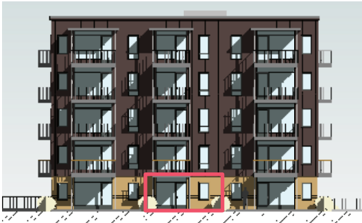
Hus B. Fasade mot sør.
